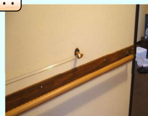
壁に補強板を入れ、横型手すりを取り付けました。
