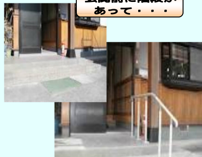
コンクリートに立上がり式の手すりを取り付けました。
