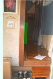
柱に縦型手すりを取り付けました。
