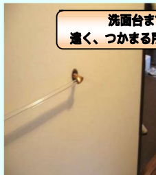
壁に補強板を入れ、横型手すりを取り付けました。
