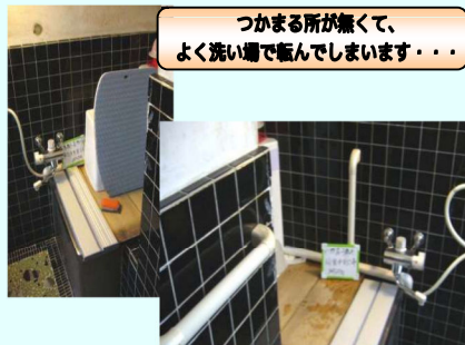
三箇所に縦型・横型手すりを取り付けました。
